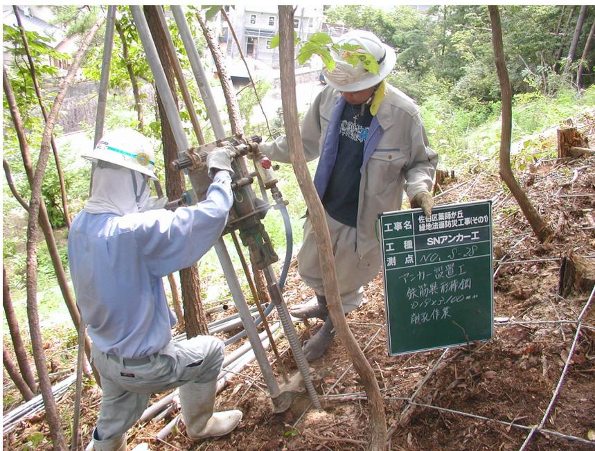
三脚ガイドセルによる削孔状況
